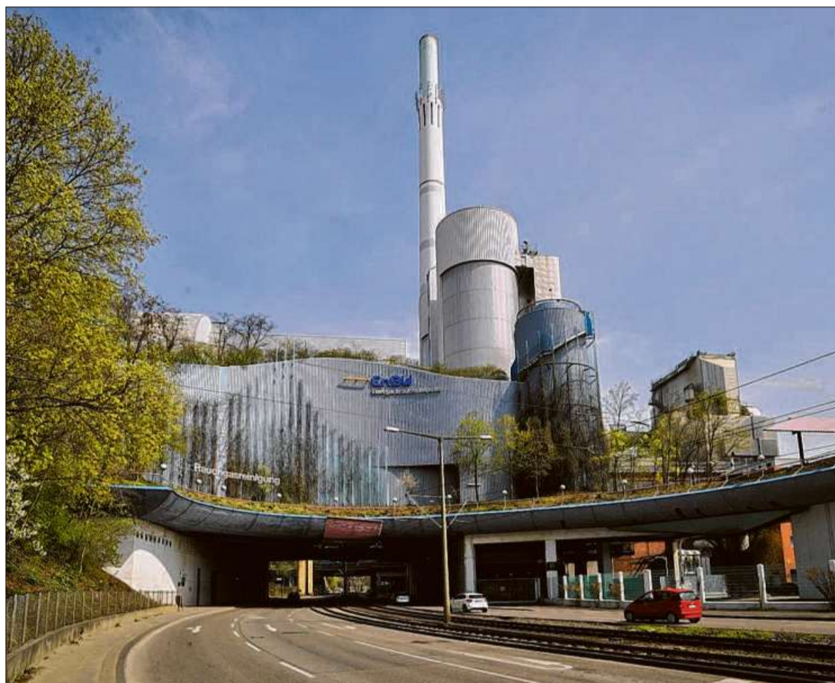
Das Kohlekraftwerk der EnBW ist in Gaisburg weithin sichtbar. Das Unternehmen beabsichtigt, den Komplex abzubauen, wenn das neue Gaskraftwerk fertig ist. Foto: Ferdinando Iannone
